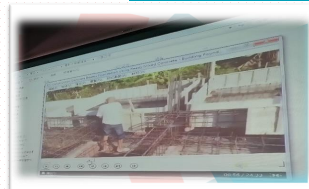
鋼筋混凝土 樑版筋的加工
